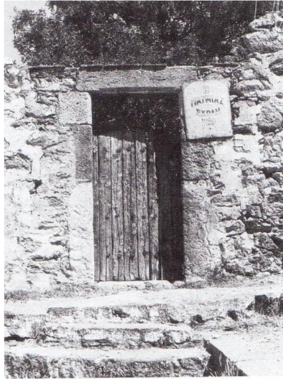
Η είσοδος στα κτίσματα της Α΄ Πατμιάδας Σχολής του 1729.
