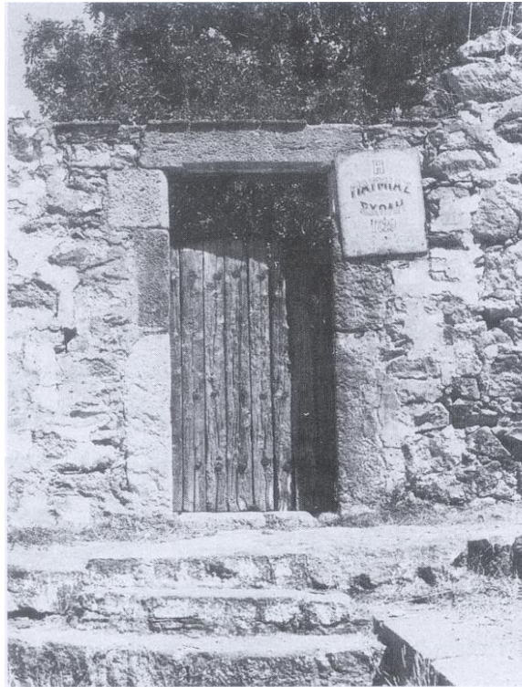
Η είσοδος στα κτίσματα της Α' Πατμιάδας Σχολής του 1729.
